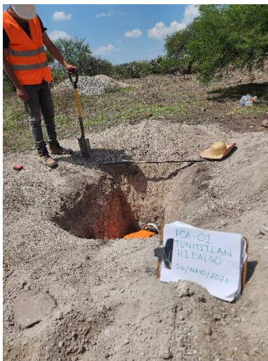
Ilustración 13 Proceso de excavación
