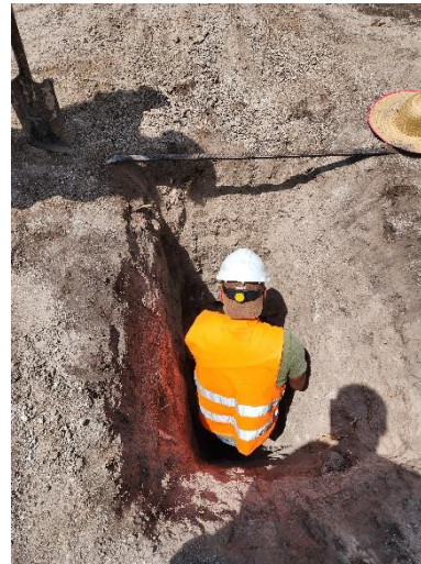
Ilustración 14 Proceso de excavación
